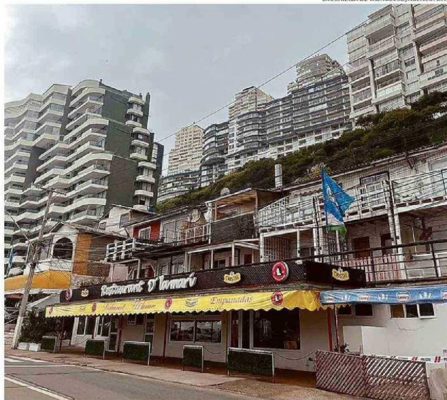
CASAS Y RESTAURANTES DE ABAJO DE "EUROMARINA II" HAN DEBIDO SACAR BARRO, AGUA Y ARENA.
