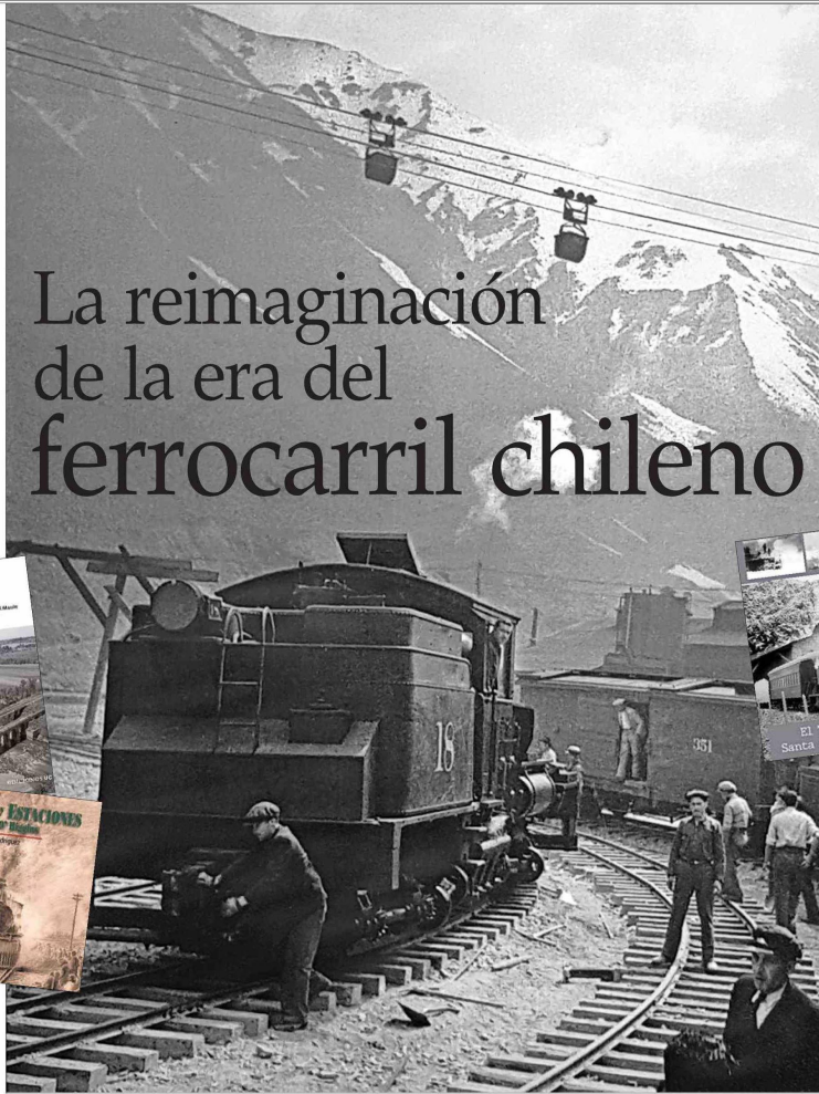
La locomotora Stay N°18 en la estación La Junta, hacia 1942. En la altura se observan los capachos del andarivel que bajaba el concentrado de cobre. El ferrocarril minero de Rancagua-Sewell marcó una época en la red de tendidos.
