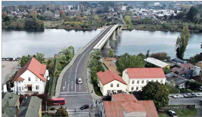
IMAGEN VIRTUAL. — El puente Cochrane tendrá 325 metros de largo, 13,5 de alto, 17,3 de ancho y cuatro cepas, tres de las cuales estarán en el lecho del río Valdivia.
