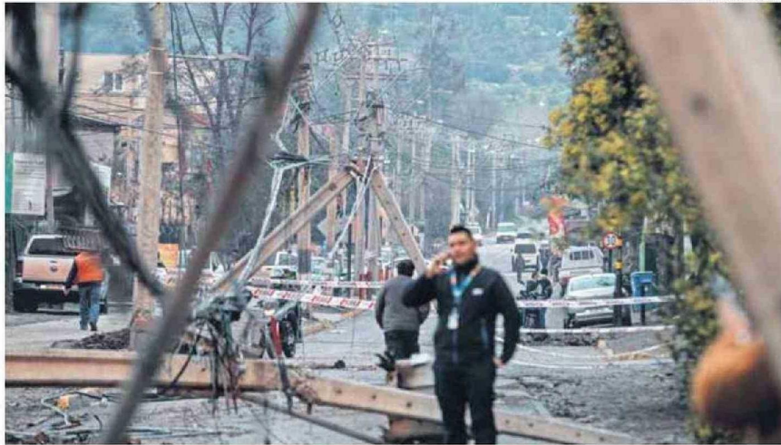
CUADRILLAS DE LAS COMPAÑÍAS ELÉCTRICAS, MUNICIPIOS Y LAS FUERZAS ARMADAS CONTINUABAN AYER EN TRABAJOS DE REPOSICIÓN DEL SERVICIO.
