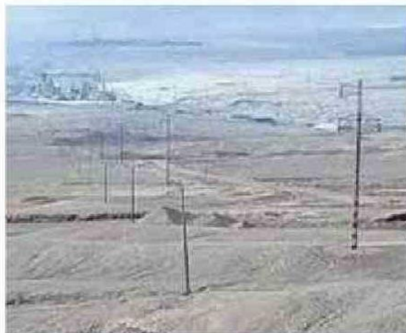
☞ NUEVA AFECTACIÓN AL SUMINISTRO ELÉCTRICO.
