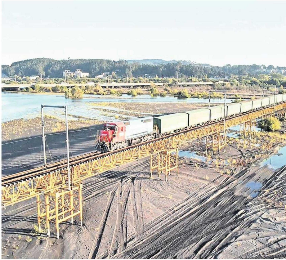
Todos los días cruzaron trenes con distintos niveles de carga para corroborar el funcionamiento del viaducto.
