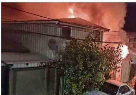
EL INCENDIO TAMBIÉN AFECTÓ A VIVIENDAS VECINAS.
