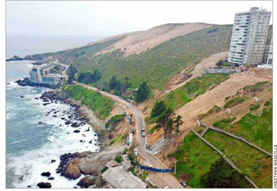
CONVIVENCIA. — Durante al menos tres meses, automovilistas deberán convivir con las faenas de instalación del nuevo colector de aguas lluvias.
