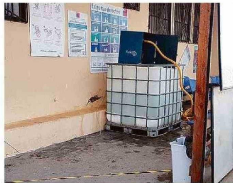
ESVAL INSTALÓ HIDROPACKS EN LOS RECINTOS DE SALUD.
