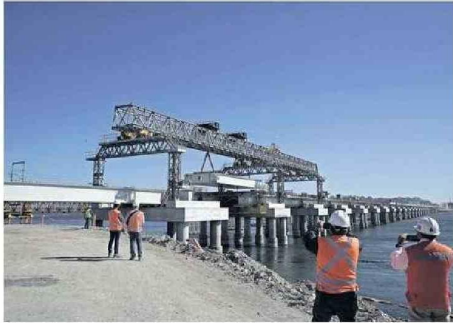
Autoridades revisaron los avances de la obra.
