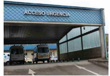
INGRESO A URGENCIA DEL HOSPITAL DE CASTRO.
