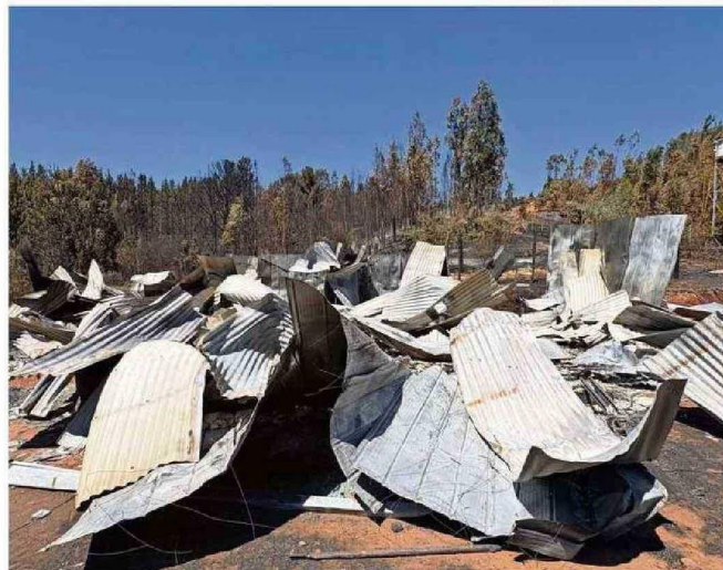
CINCO CASAS Y TRES GALPONES RESULTARON DESTRUIDOS POR EL INCENDIO QUE PARTIÓ EN COIPUCO.
