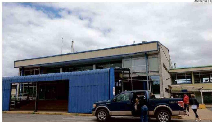
EL PROYECTO CONSIDERA LA AMPLIACIÓN DE LAS INSTALACIONES DE CAÑAL BAJO.
