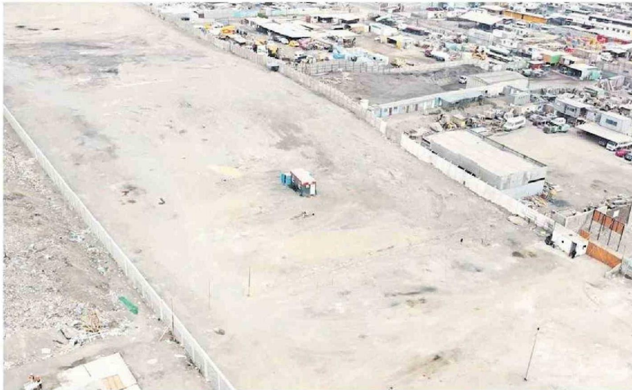
EL CIERRE PERIMETRAL CONSIDERA EL MURO DE HORMIGÓN DE 850 METROS LINEALES, ADEMÁS DE LA HABILITACIÓN DE INFRAESTRUCTURA.
