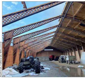
DAÑOS.— Las caídas de árboles y ráfagas de viento provocaron voladuras de techos y daños sobre infraestructura de predios agrícolas.
