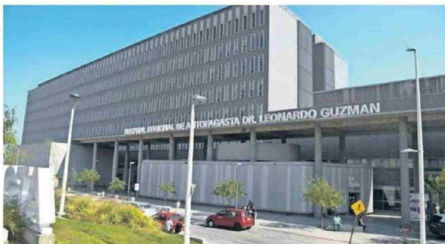
HAY MÁS DE 30 CIRUGÍAS QUE SE HAN TENIDO QUE SUSPENDER POR LA FALLA DEL SISTEMA DE CLIMATIZACIÓN.
