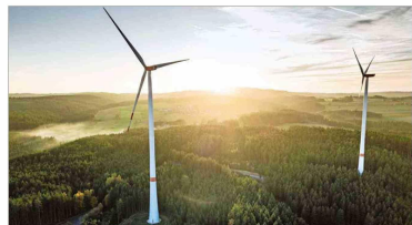
El proyecto Viento Sur considera la construcción y operación de un parque eólico compuesto por 43 aerogeneradores, con una potencia instalada del orden de 215 MW.
