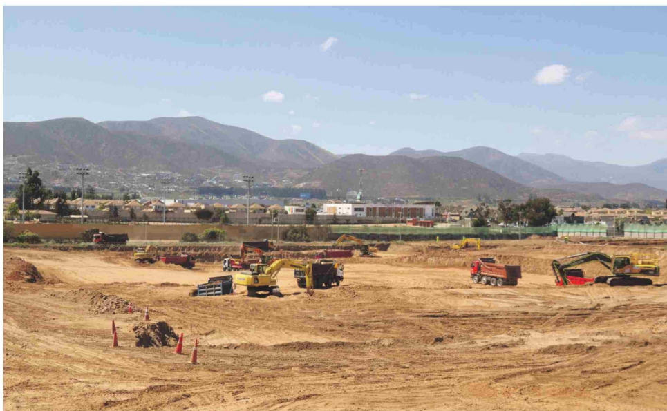
Entre las medidas implementadas por la empresa contemplan el mejoramiento de los accesos a la obra para reducir el polvo, la humectación de caminos y del terreno de la obra para reducir el polvo en suspensión.
