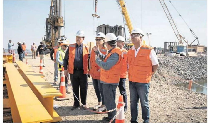
Autoridades locales visitaron las obras de recuperación del puente Ferroviario junto al presidente de EFE.
