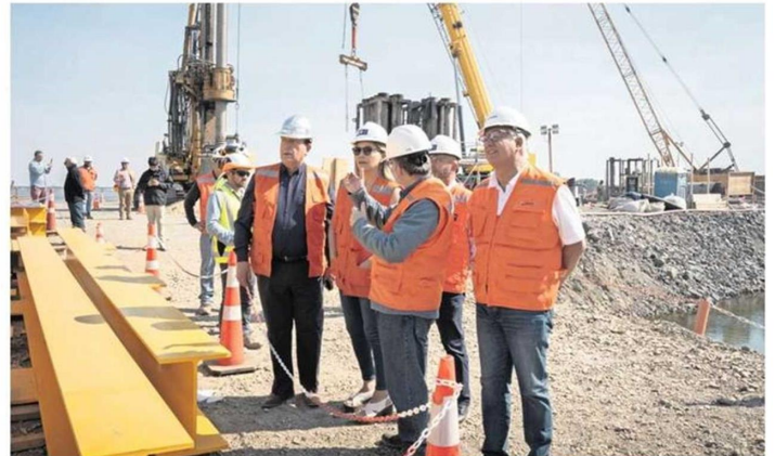
Autoridades locales visitaron las obras de recuperación del puente Ferroviario junto al presidente de EFE.
