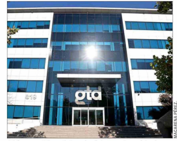
Gtd posee 10 recintos de data centers ubicados en Chile, Perú y Colombia.
