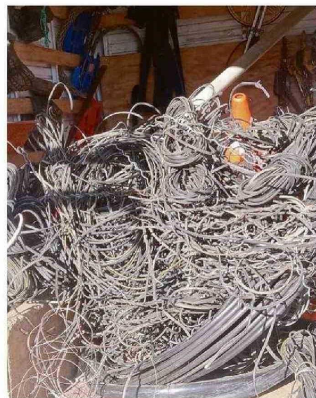
EL PESO DE TODA LA LÍNEA DE CABLEADO RESULTA INSOSTENIBLE.
