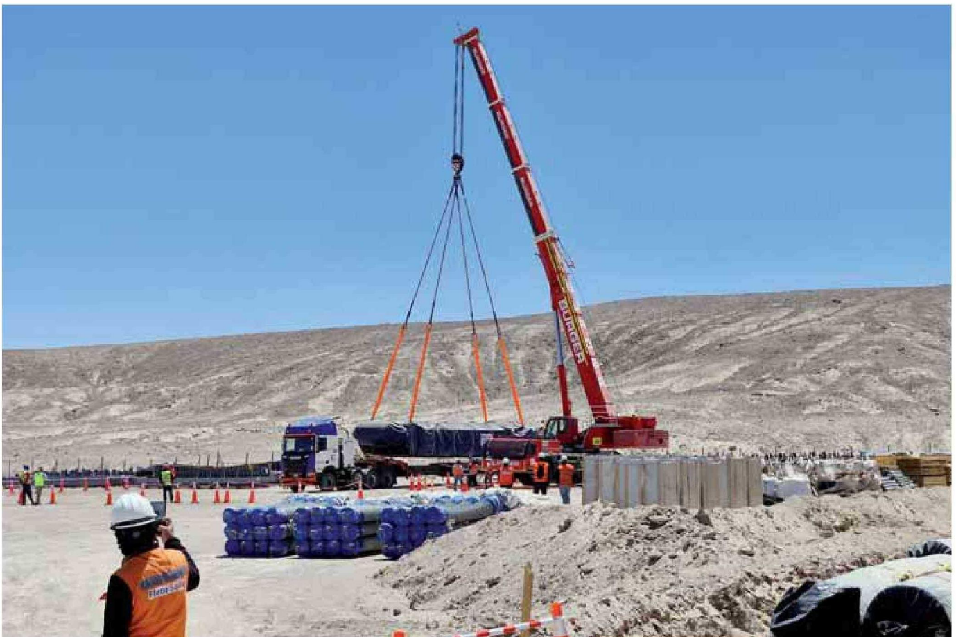
❖ Llegada de equipos críticos a faena.
