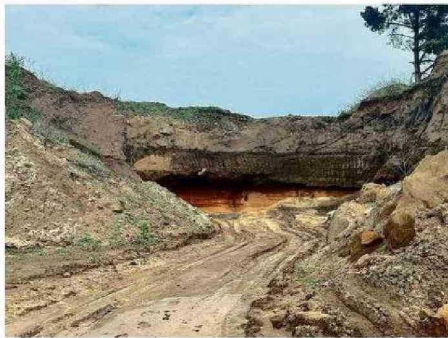
EL DAÑO AL TERRENO POR EXTRACCIÓN ILEGAL DE ÁRIDOS.
