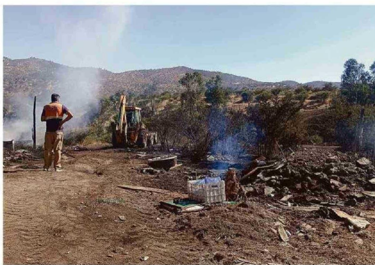
DESDE LA MUNICIPALIDAD YA SE ENCUENTRAN REMOVIENDO ESCOMBROS.
