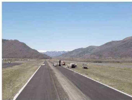
OBRAS REALIZADAS EN AERÓDROMO DE LONQUIMAY.
