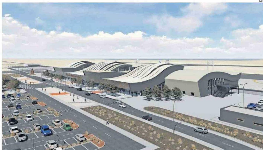
LA PANORÁMICA DEL AEROPUERTO DESIERTO DE ATACAMA.
