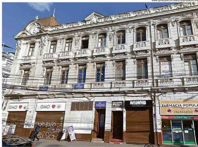
RECINTO LLEVA 18 AÑOS FUNCIONANDO EN LA CIUDAD PUERTO, FRENTE A LA PLAZA VICTORIA.
