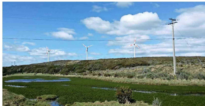
Parque eólico de Pecket Energy.
