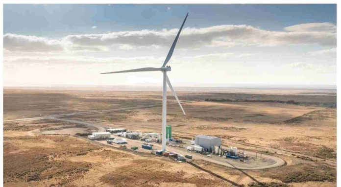
LA PLANTA HARU ONI EN MAGALLANES ES LA ÚNICA EN CHILE QUE PRODUCE COMBUSTIBLE CARBONO NEUTRAL EN BASE A HIDRÓGENO. PERO ES EXPERIMENTAL.
