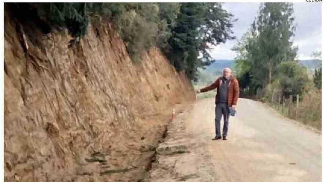
EN LA IMAGEN SE VE PARTE DEL MEJORAMIENTO PREPARATORIO DE LA VÍA U-300, DE CARA A SU ASFALTADO.
