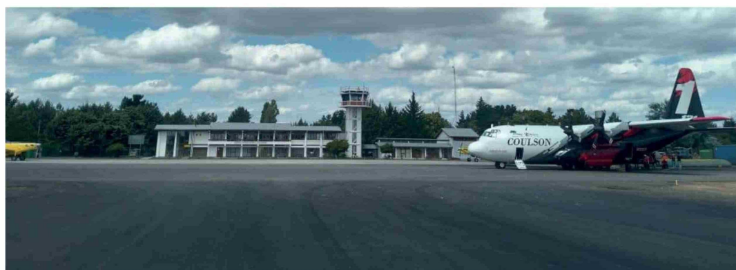
LAS INICIATIVAS APUNTAN a extender el largo y ancho de la pista de la terminal aérea local.
