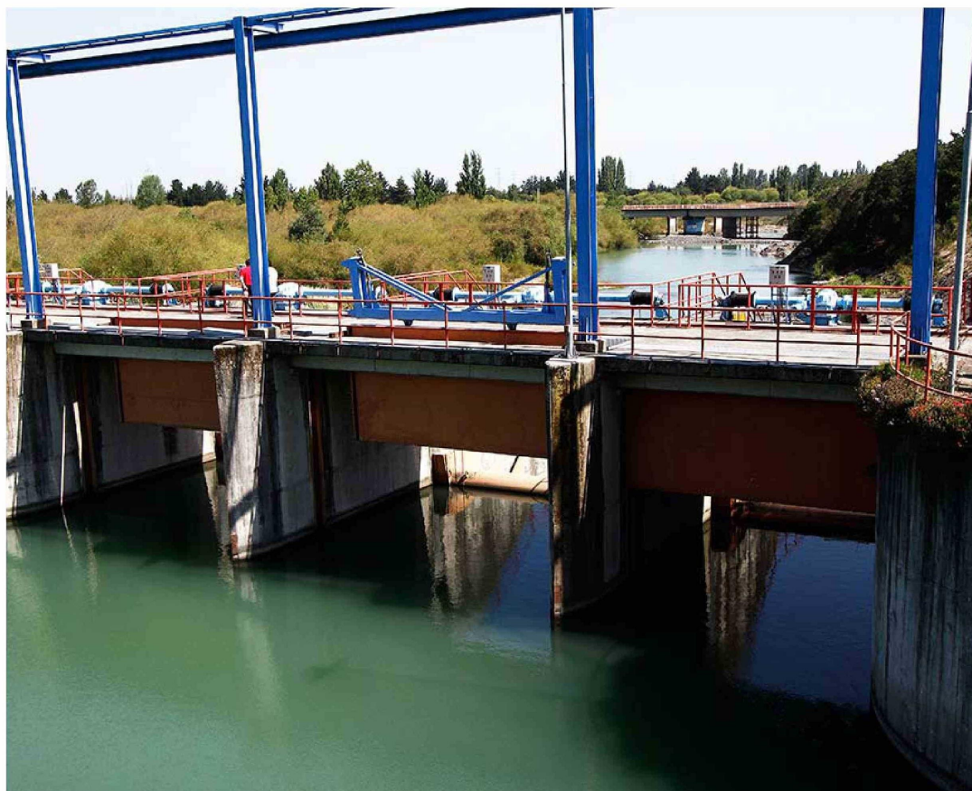
En la bocatoma Tucapel, se extrae agua del río Laja para alimentar el canal Laja-Diguillín.
