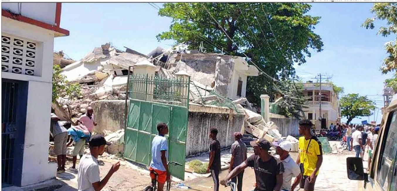
La residencia de un obispo fue destruida, en la comuna sureña de Les Cayes. Toda la zona sur de Haití sufrió los embates del terremoto.
