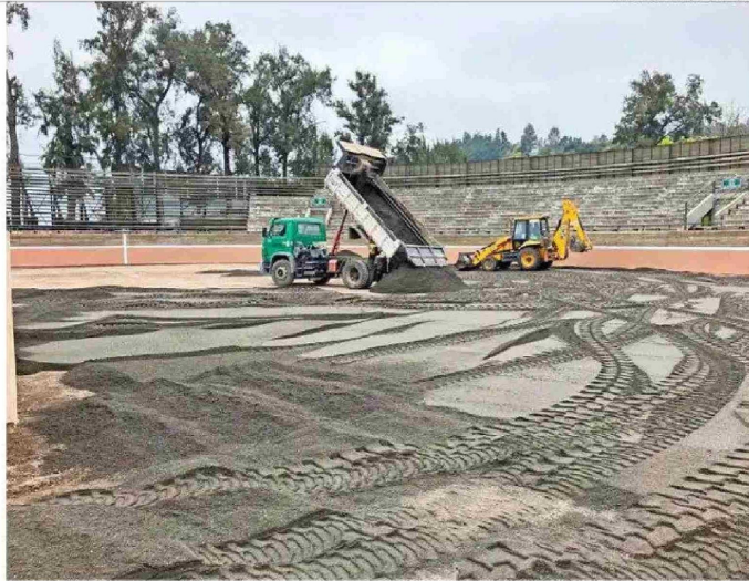
Diversos trabajos se realizaron en la medialuna monumental de Curicó.
