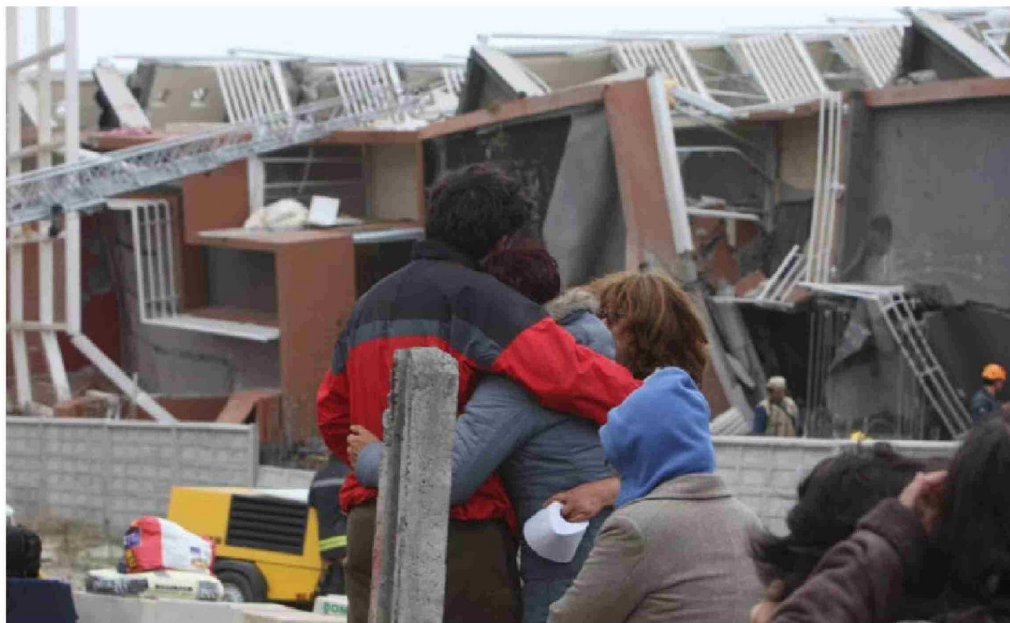
► El desplome del edificio Alto Río en Concepción, una de las imágenes más simbólicas de la tragedia.
