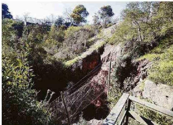
EL SOCAVÓN DE LA CALLE EKLO니아 PREOCUPA A VECINOS DE JARDÍN DEL MAR.
