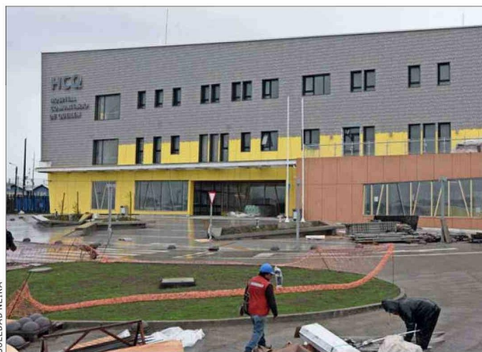
CENTRO ASISTENCIAL. —El Hospital de Queilén está prácticamente terminado, diez años después de que se quemara el anterior edificio.
