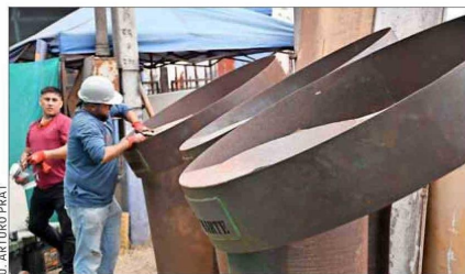
Trabajos. En los talleres de la U. Arturo Prat se terminan los últimos detalles previos a la instalación de los tótems donde irá cada uno de los astros.
