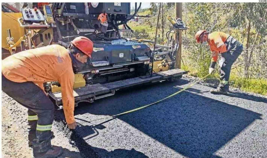
EN ÑUBLE SE ASFALTAN ANUALMENTE CERCA DE 80 KILÓMETROS, SEGÚN PRECISARON DESDE EL MOP. RED VIAL LLEGA A LOS 4.779 KM EN LA REGIÓN.
