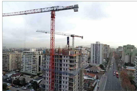
El trabajo reveló que en 64% de los municipios fiscalizados existe un correcto acceso de datos de permisos de edificación. En el 36% hubo incumplimientos.
