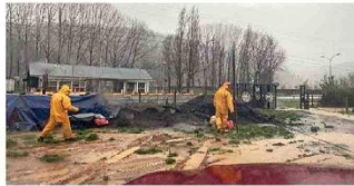
Habilitación Ruta de la Madera, en la comuna de Santa Juana.
