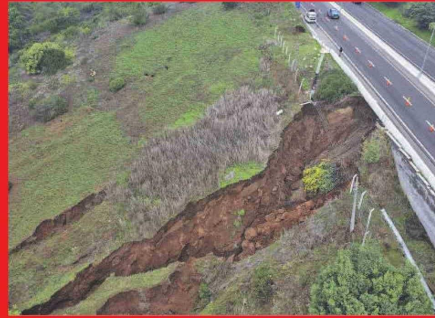
El socavón en el Camino Internacional, a la altura de Concón, tiene más de 20 metros de extensión. / TWITTER
