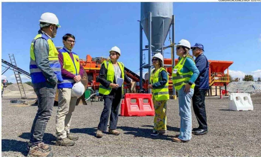
LAS AUTORIDADES SECTORIALES REGIONALES Y DE LA COMUNA DE MARIQUINA VISITARON LAS OBRAS QUE COMENZARON A DESARROLLARSE EN LA PISTA.
