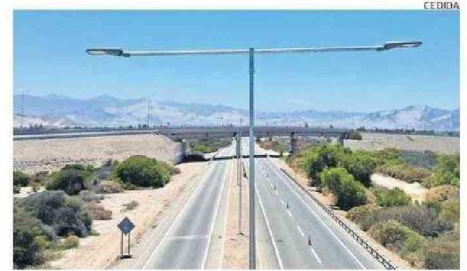
TRABAJO LLEVA UN 35% DE AVANCE EN LAS CERCANÍAS DE COPIAPÓ.
