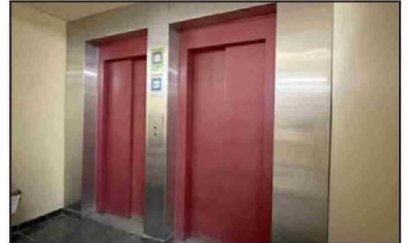
Comenzaron trabajos de mejoramiento de los ascensores de la Delegación Provincial.
