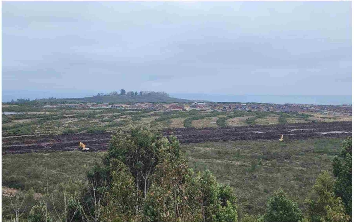
ENTRE JUNIO Y LA PRIMERA SEMANA DE JULIO, SE EJECUTARON DIVERSOS TRABAJOS DE MOVIMIENTO DE TERRENO EN EL HUMEDAL VALLE VOLCANES DE PUERTO MONTT.
