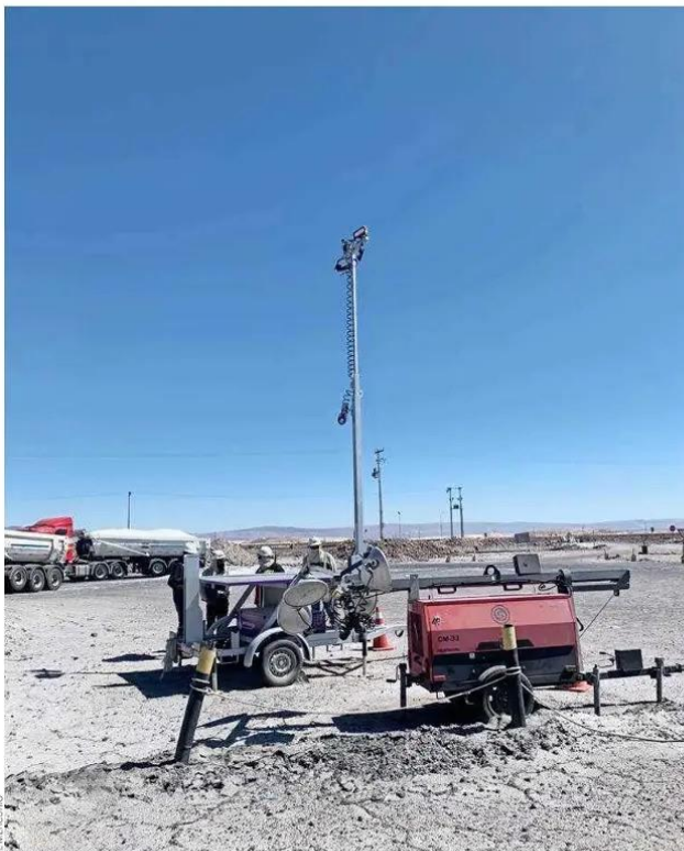
Actualmente la gran oferta de equipos para generar energía eléctrica a partir del sol, cuentan con certificaciones internacionales que permiten tener un estándar de seguridad.
