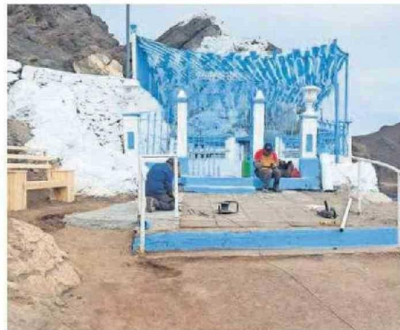
EN TALTAL SE REALIZARON TRABAJOS EN LA GRUTA DE LA PUNTILLA.
