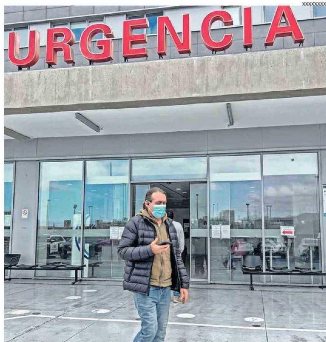
EL MANTENIMIENTO Y LA INSPECCIÓN DEL EDIFICIO ES DE RESPONSABILIDAD DE LA CONCESIONARIA SIGLO XXI
