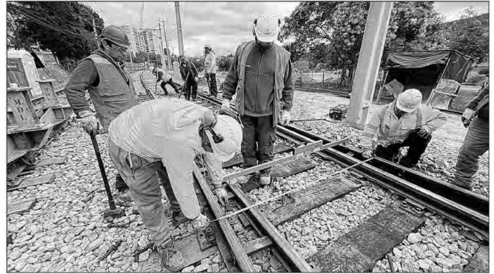
Tras retirar los vagones, los trabajos continuaron en las vías hasta reanudar el servicio normal.
